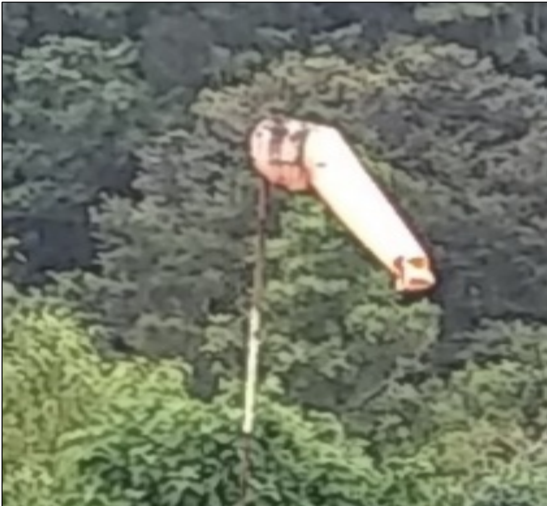
Fotografía No. 7: Condición de la manga veleta
