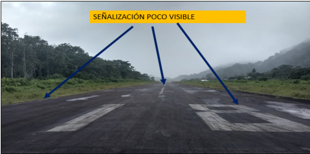
Fotografía No. 8: Condiciones de señalización de la pista
